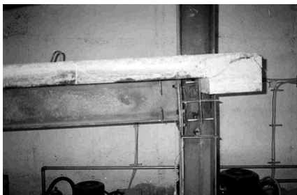
E3 (Pilar Metálico, M-)
