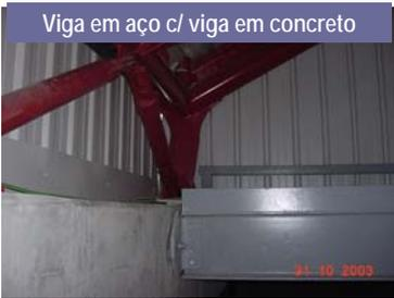
Viga em aço c/ viga em concreto
