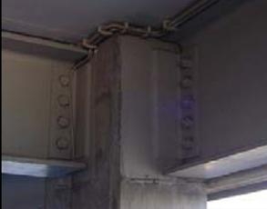
Viga em aço c/ pilar de concreto
