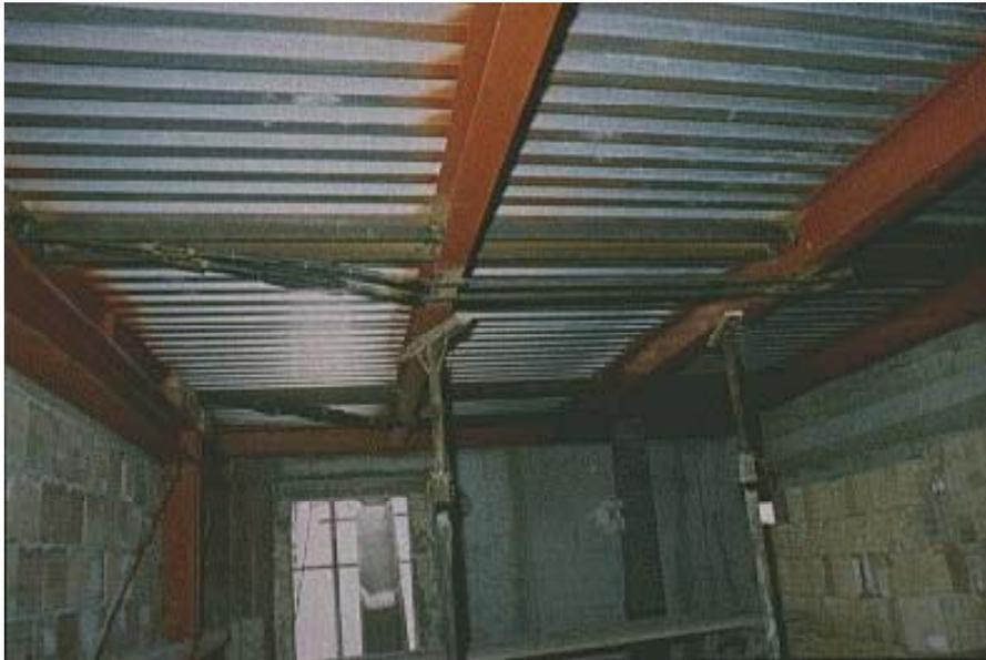
**Figura 2 – Troca de pisos por deck metálico**
