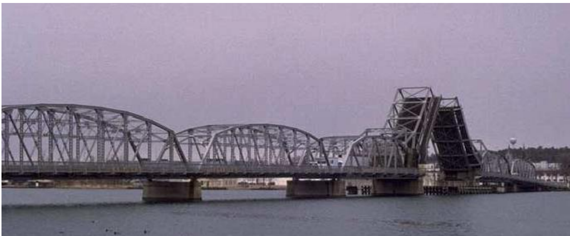
Figura 6 – Vista geral da “Michigan Street Bridge”
