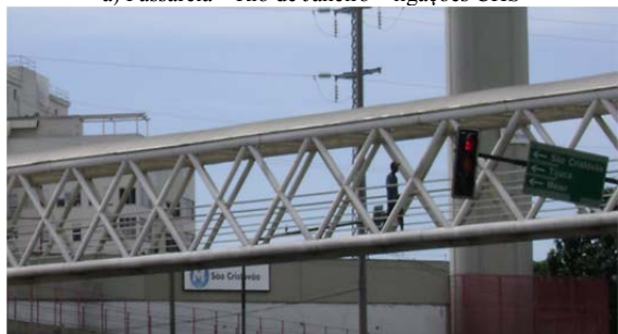
c) Passarela – Rio de Janeiro – ligações CHS
