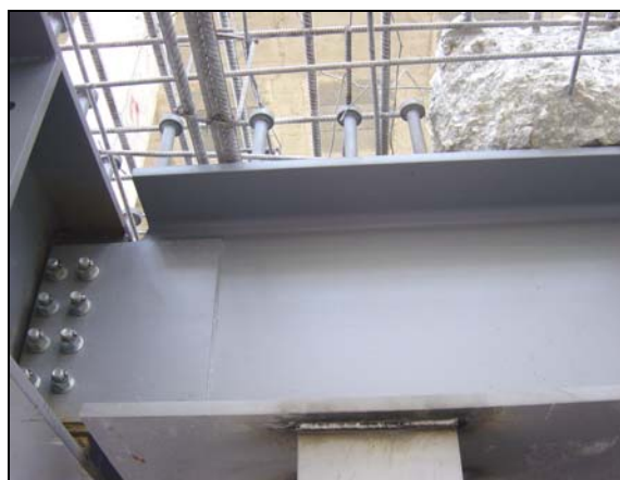
a) Ligação entre vigas secundária e principal
