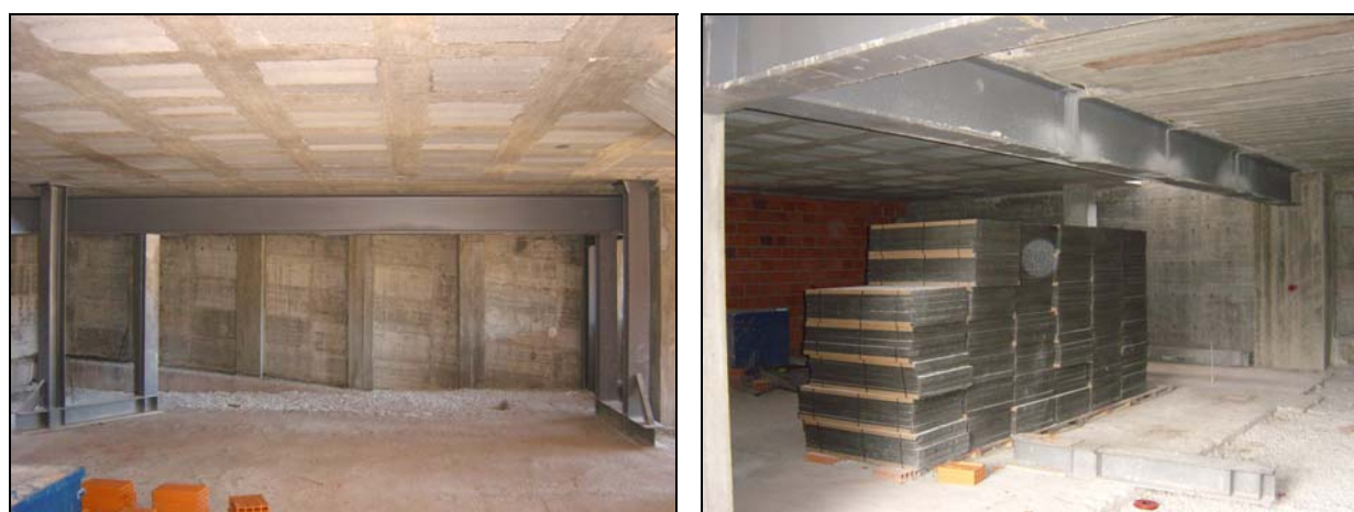
a) apoios provisórios - viga metálica
