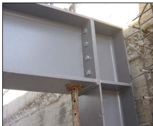
b) Ligação viga principal - pilar
