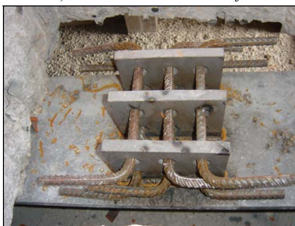
c) Pormenores dos conectores tipo perfobond rib
