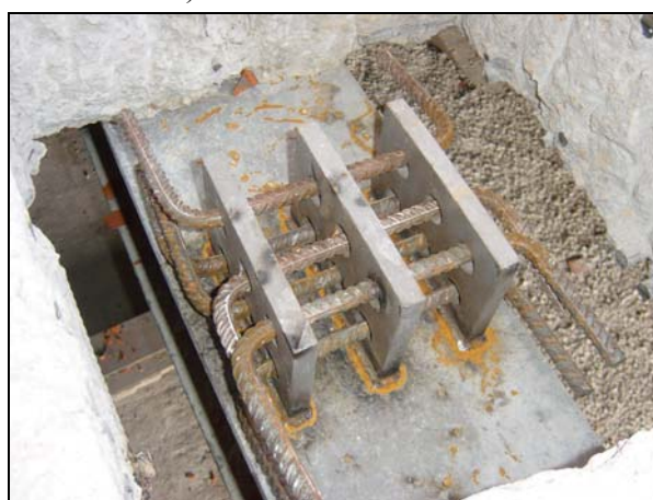
c) Pormenores dos conectores tipo perfobond rib
