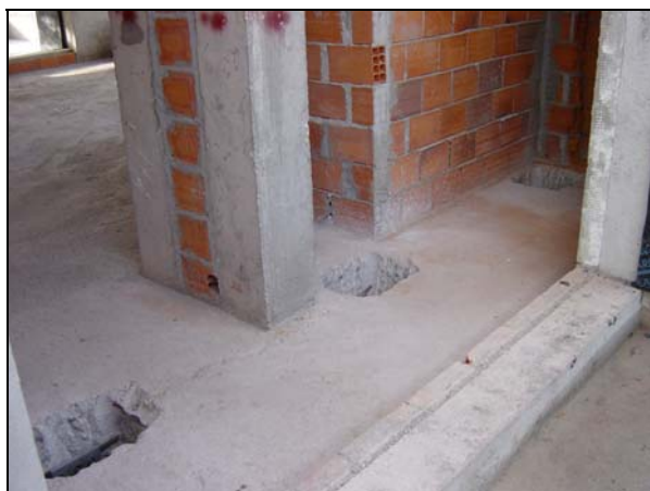
a) Abertura dos orifício na laje
