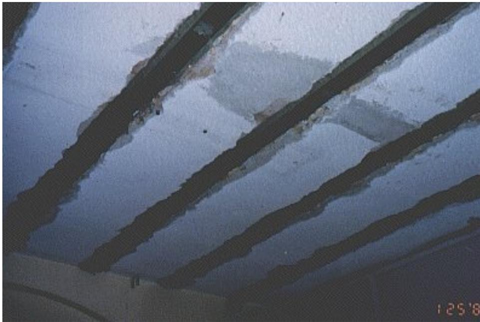
**Figura 2.18 – Reforço de lajes de concreto**
