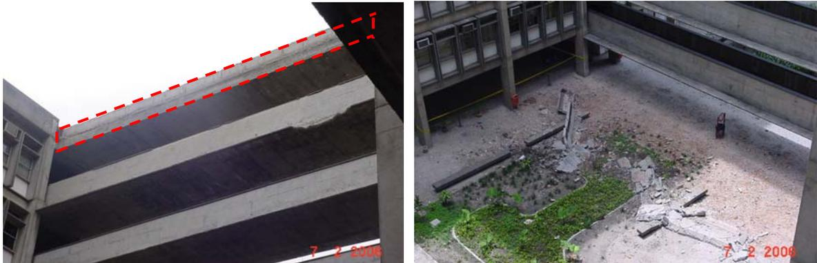
**Figura 1.3 – Localização da viga não estrutural de tapamento em concreto armado e seus escombros após o colapso**
