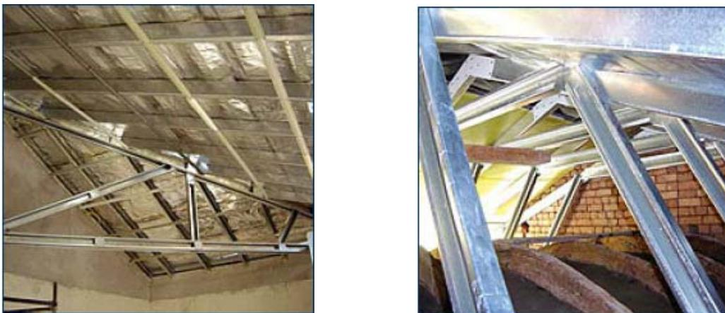
**Figura 2.36 – Estrutura de Aço do Telhado (Igreja de Nª Srª do Carmo) [8]**
