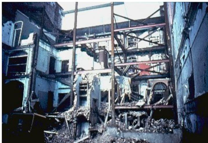
**Figura 2.25 – Demolição interna após a instalação parcial da nova estrutura**
