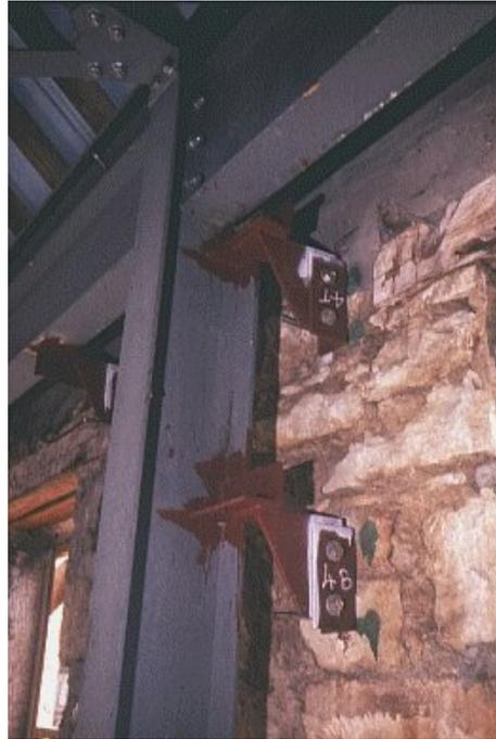
**Figura 2.12 – Inserção de pilares para contenção de paredes de alvenaria [1]**
