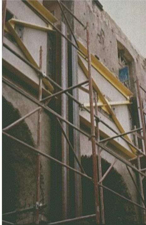
**Figura 2.13 – Contraventamento em “X” de parede de alvenaria existente**
