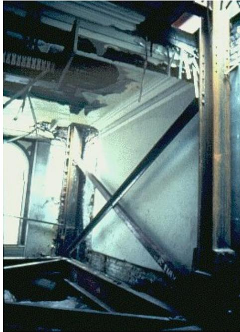
**Figura 2.24 – Instalação de colunas antes da demolição com contraventamento provisório**
