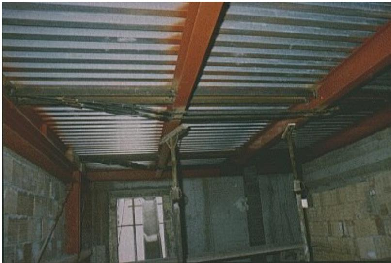
**Figura 2.5 – Troca de pisos por *deck* metálico**
