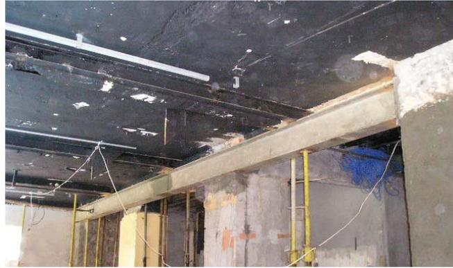
**Figura 2.40 – Vista geral da Viga W410 Instalada [1]**
