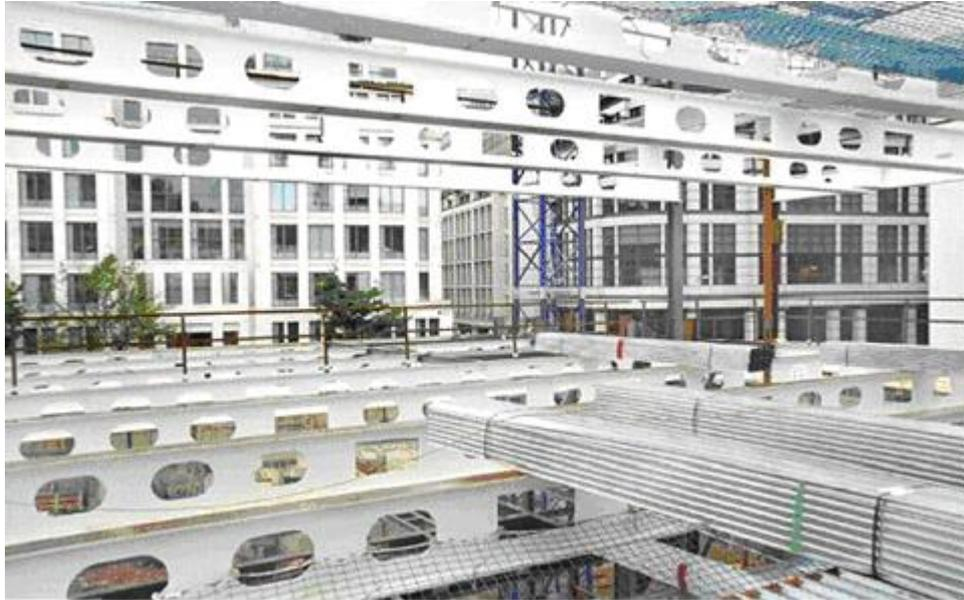
**Figura 1.5 – Vigas com aberturas de formas variadas [15]**
