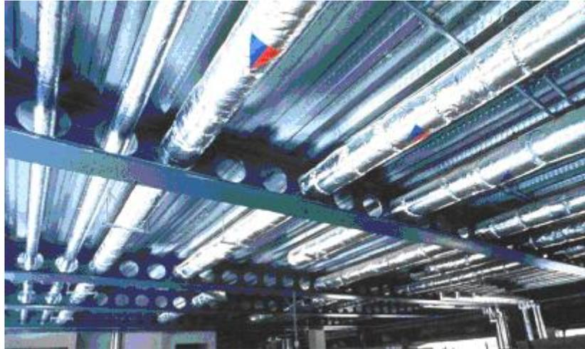
**Figura 2.2 – Viga com furos regulares {15}**
