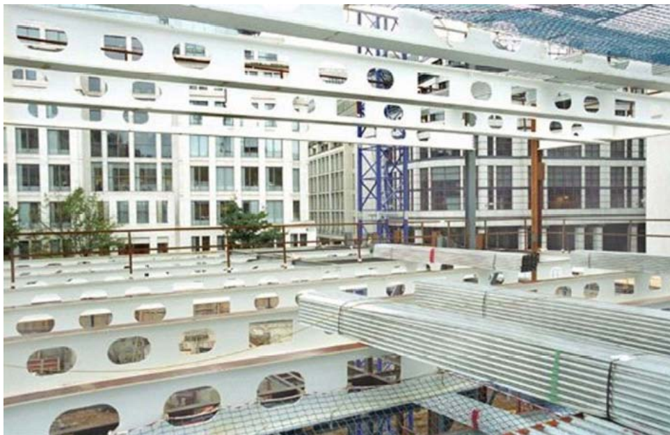
Figura 1.6 – Vigas com aberturas de formas variadas [14]
